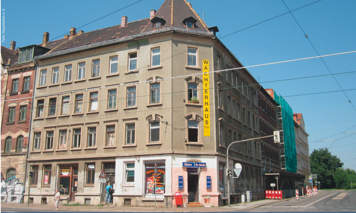
Die Fassade spricht für sich: Ein Wächterhaus in Leipzig-Möckern.
