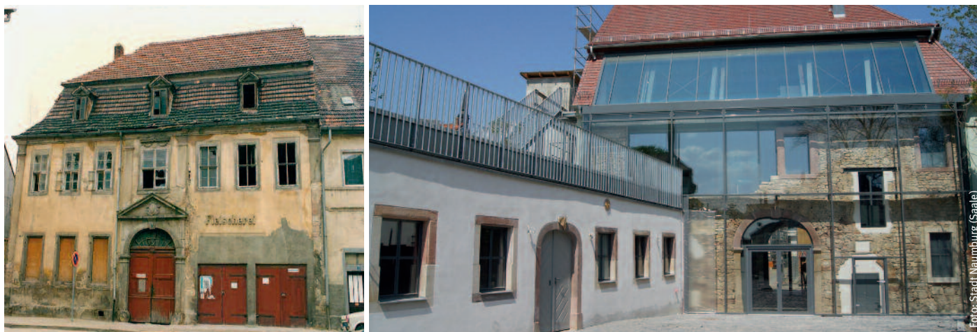
Das Architektur- und Umwelthaus in Naumburg an der Saale: Gelungene Kombination aus alt und neu, aus Stadtsanierung, Bürgerwille und zwei Millionen Fördergeldern. Nicht alle Naumburger konnten vor der Sanierung (links) an die Rettung des Gebäudes in der Wenzelsgasse glauben.
